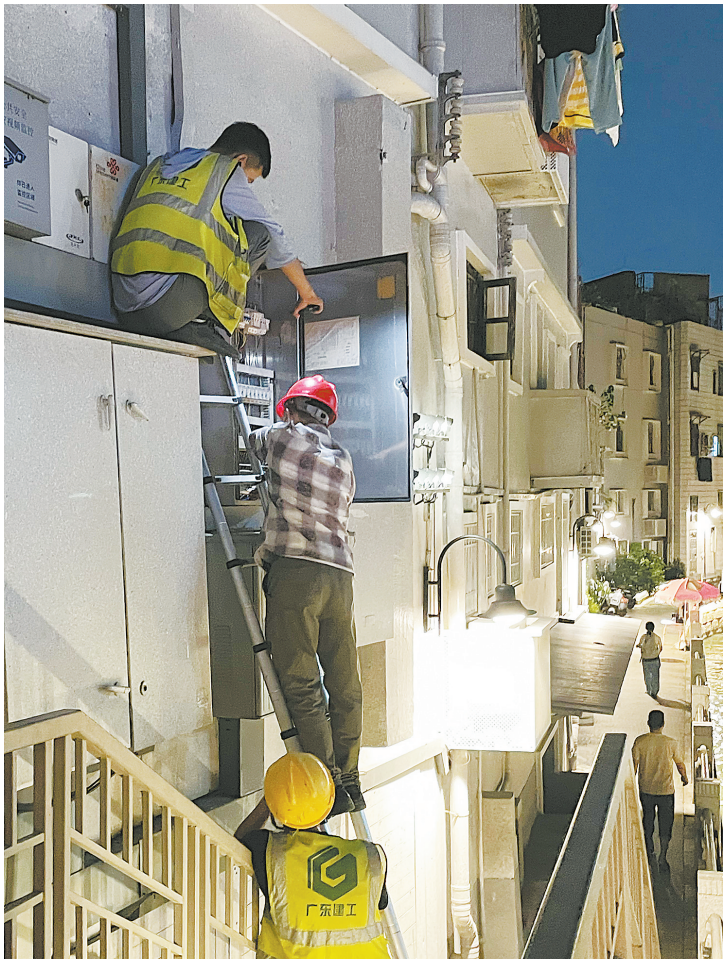
维修人员正在恩宁路对路灯电箱进行检修
