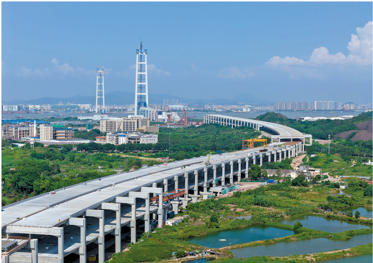
狮子洋大桥锚碇扎根珠江两岸，通道全线建设进度已过半 羊城晚报记者 曾育文 通讯员 张东 钟晓斌 卢志勉 摄
