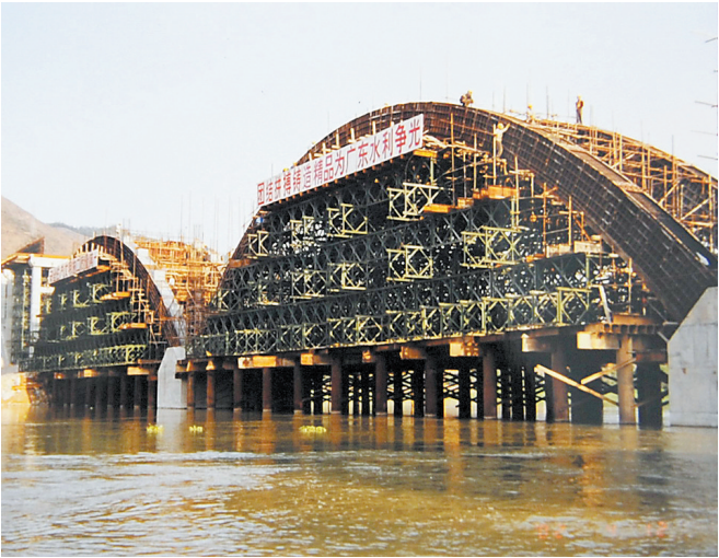
东深供水改造工程跨河道拱圈 粤海水务供图
