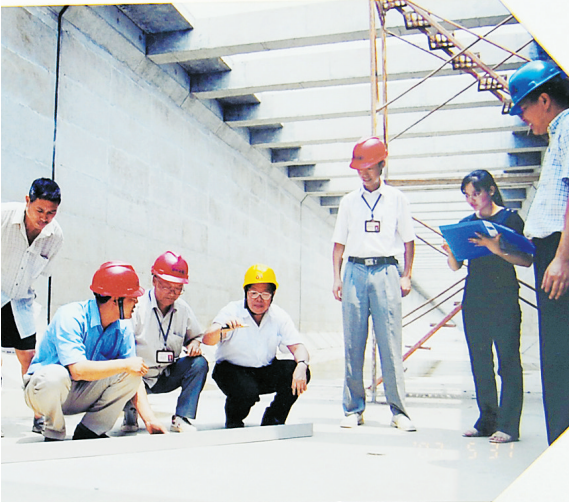
东深供水改造工程金湖渡槽施工情况检查 粤海水务供图
