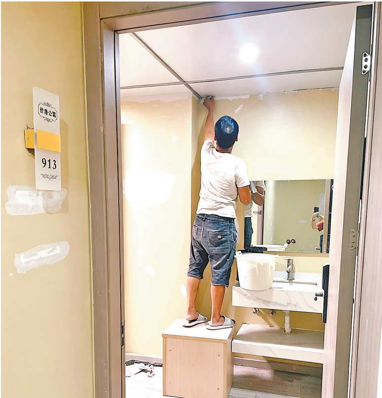
施工人员在9楼装修
