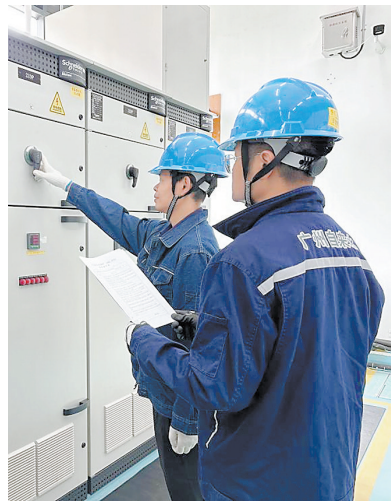
运行人员进行停电操作
