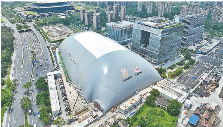
白云展览中心项目引入气承式全封闭基坑气膜施工工艺 通讯员供图
