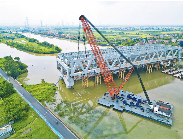
正在进行吊装的狮子洋通道跨西樵水道钢桁梁桥 通讯员 陈于思 摄
