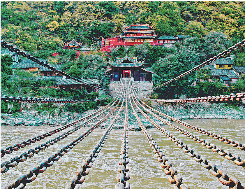
泸定桥往年大修时的照片，可以清晰看到13根铁索的分布 泸定县委宣传部提供
