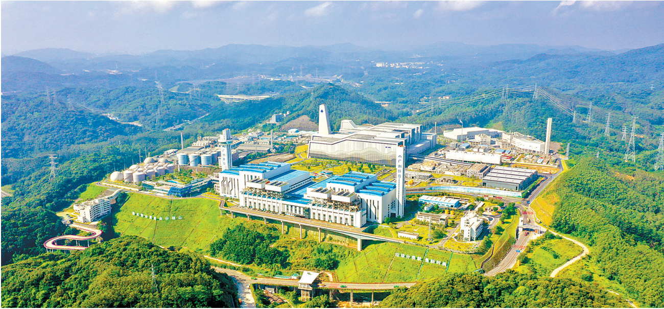
广州环投集团建设运营的福山循环经济产业园
