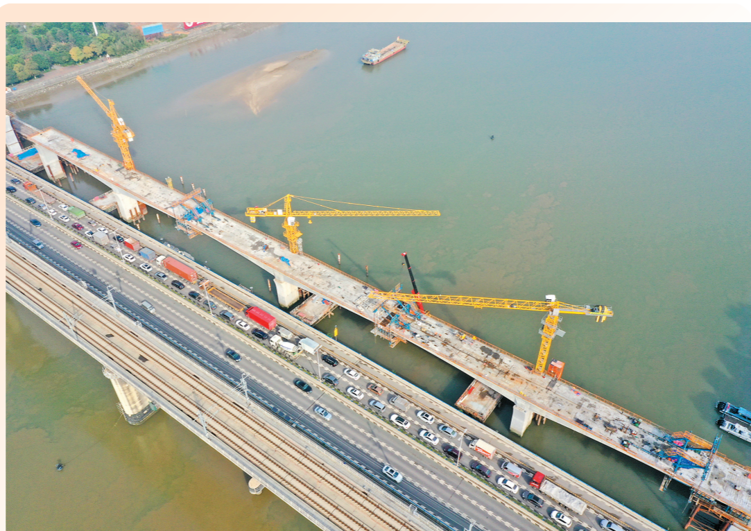
水中墩连续梁合龙
