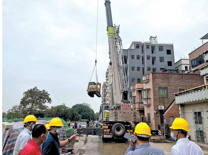
大塘镇宅基地违法建筑强制拆除现场
