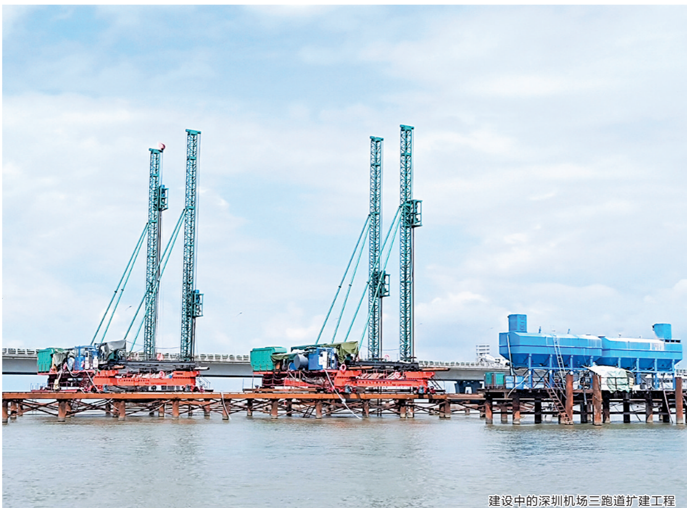
建设中的深圳机场三跑道扩建工程
