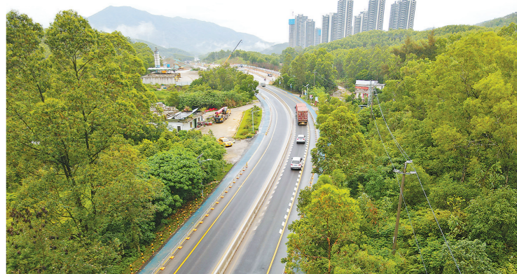
整治提升后的G228国道赤石广场段
