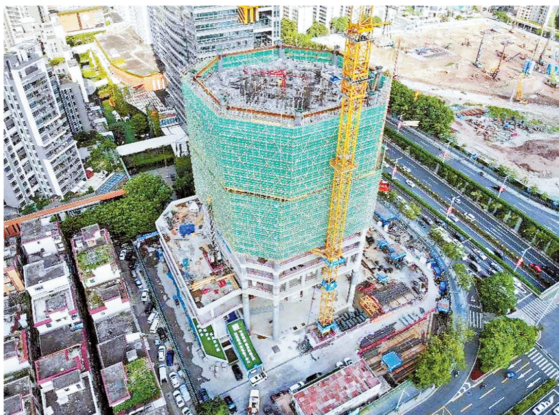
近期城发大厦施工现场现状 受访者供图
