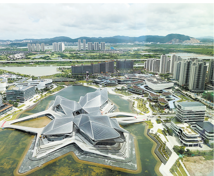
珠海机场上半年完成旅客吞吐量530.47万人次,图为珠海金湾航空新城
