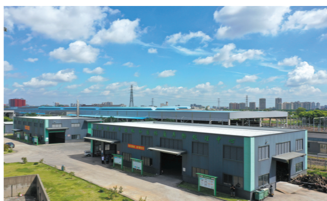
茶山镇厨余垃圾处理中心和茶山镇大件垃圾和园林废弃物处理中心毗邻而建
