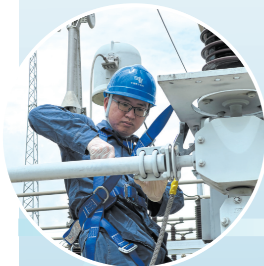
供电检修人员对变电站设备进行全面检查,消除隐患,确保设备健康运行 秦康 摄
