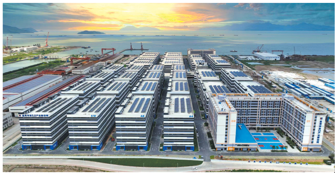
华发5.0产业新空间——平沙电子电器产业园已全面建成并投入使用 受访者供图
