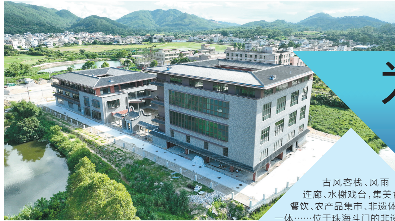
珠海斗门非遗传承基地综合体项目主体建筑已成形
