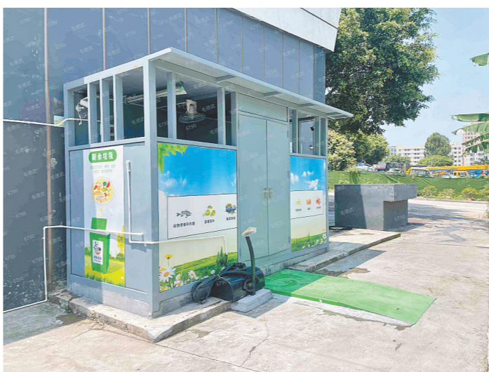
石岩街道厨余垃圾收集暂存点成品箱体改造后
