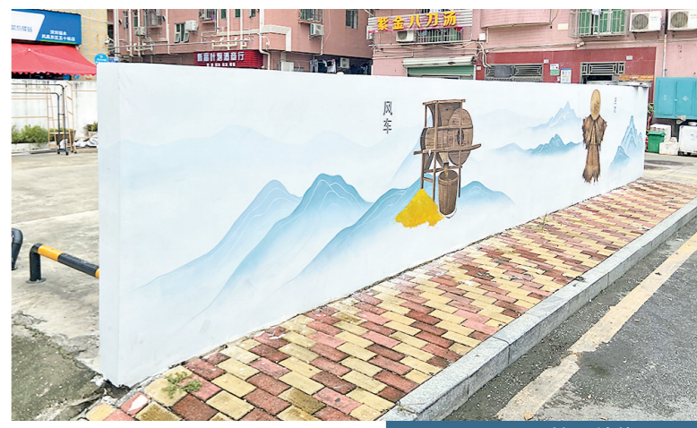
围墙彩绘施工后
