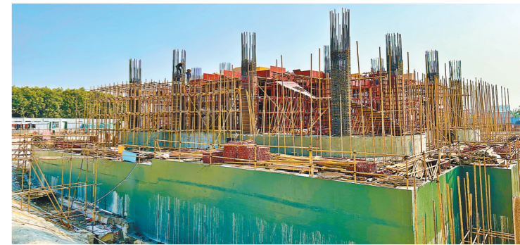
产业城一期地下结构完工
