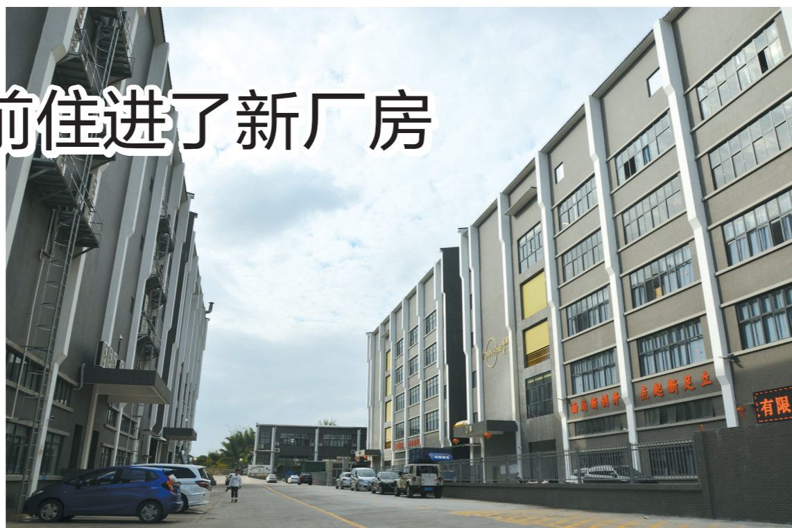
外沙村工业集聚区“工改”腾挪园内崭新的厂房
