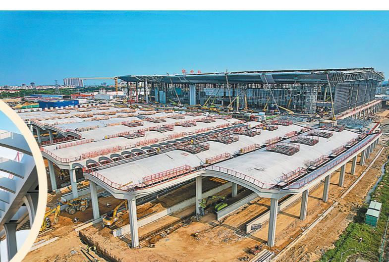
诉记者，北雨棚由236条曲率半径、弧长均不等的圆弧梁构成结构“骨架”，整体圆弧多曲率控制的根本在于对主龙骨的弧度控制。
