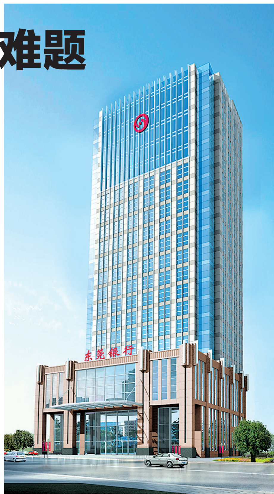
东莞银行总部大楼
