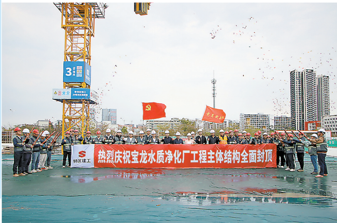
宝龙水厂项目主体结构全面封顶
